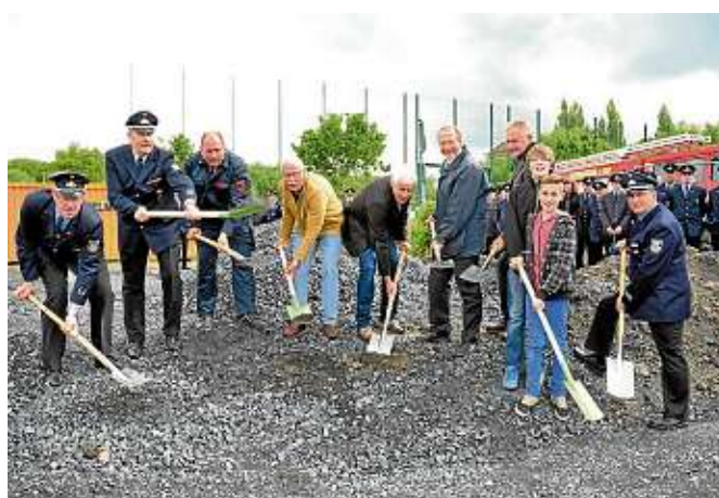
Bürgermeister Roland Schäfer und die Spitze von Feuerwehr, Verwaltung und Politik gaben mit dem ersten Spatenstich das Startsignal für den Bau des neuen Rünther Feuerwehrgerätehauses. ■ Foto: Grzelak
