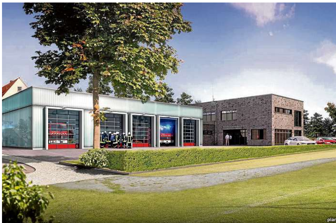
Das neue Feuerwehr-Gerätehaus soll aus einer Fahrzeughalle aus Stahl und einem zweigeschossigen Sozialgebäude mit Schulungs- und Besprechungsräumen sowie einer Atemschutzwerkstatt bestehen. ■ Abbildung: Archiv
